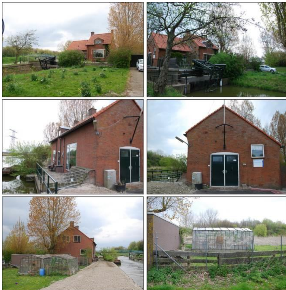
Figuur 3.2. Impressie van het plangebied. Links- en rechtsboven: aanzicht van het gemaal en de dienstwoning. Links- en rechtsmidden: de noordwestzijde van de dienstwoning gelegen aan de Strijp. Linksonder: zuidoostzijde van de woning. Rechtsonder: de kleine kas en tuin.
