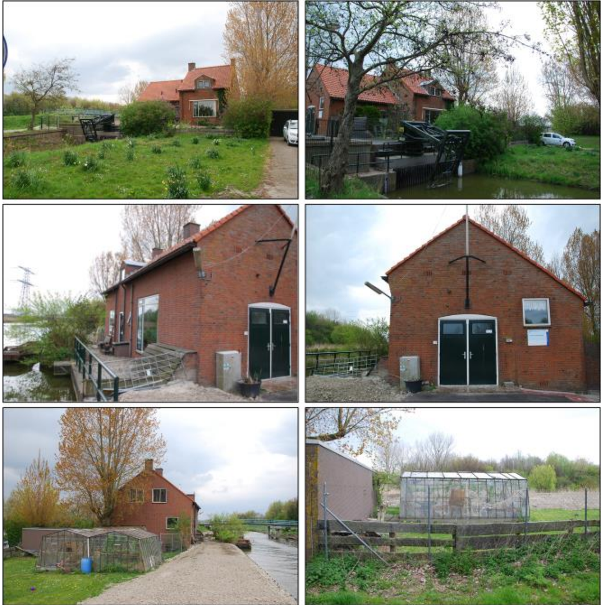
Figuur 3.2. Impressie van het plangebied. Links- en rechtsboven: aanzicht van het gemaal en de dienstwoning. Links- en rechtsmidden: de noordwestzijde van de dienstwoning gelegen aan de Strijp. Linksonder: zuidoostzijde van de woning. Rechtsonder: de kleine kas.
