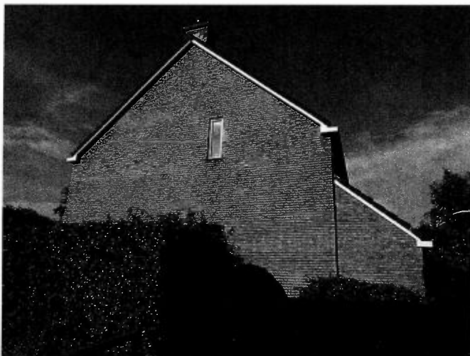
Figuur 1: gevelplanken waaronder paarverblijfplaatsen zijn aangetroffen.
