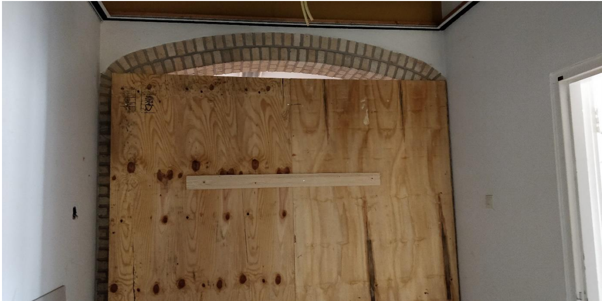
Foto 16: Dichtgezette openingen met een boog van metselwerk.
