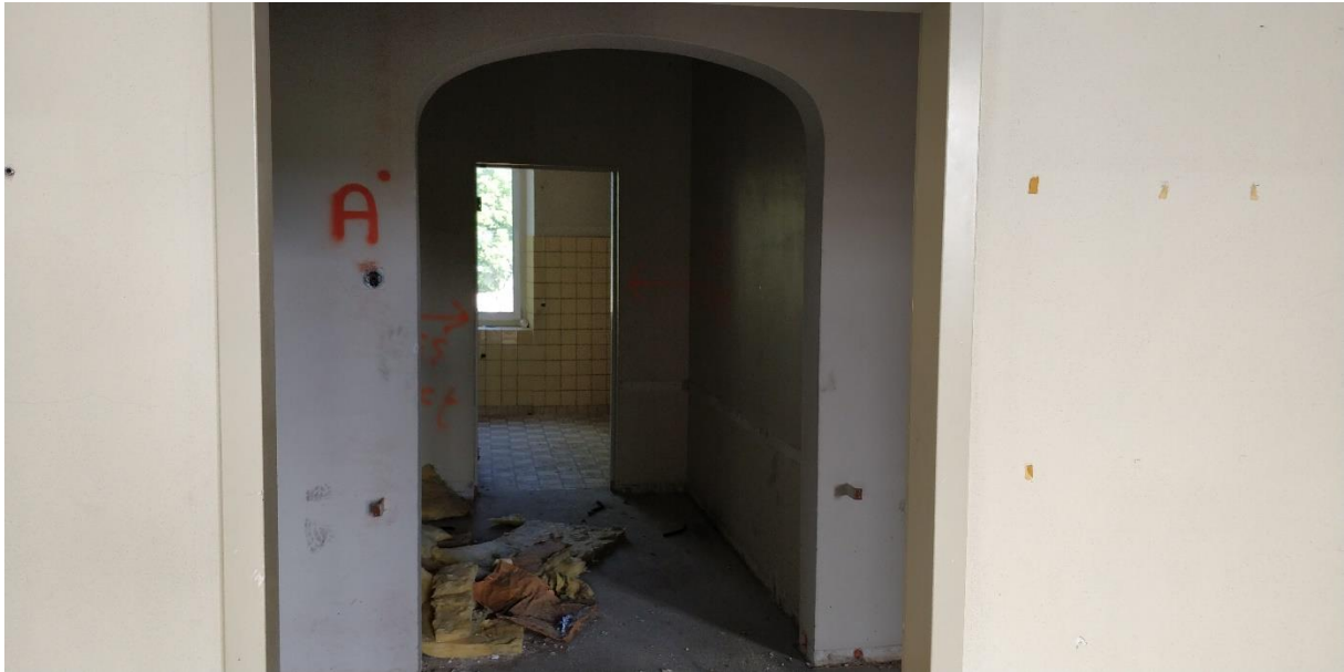
Foto 55: Bogen bij kamers op de tweede verdieping.
