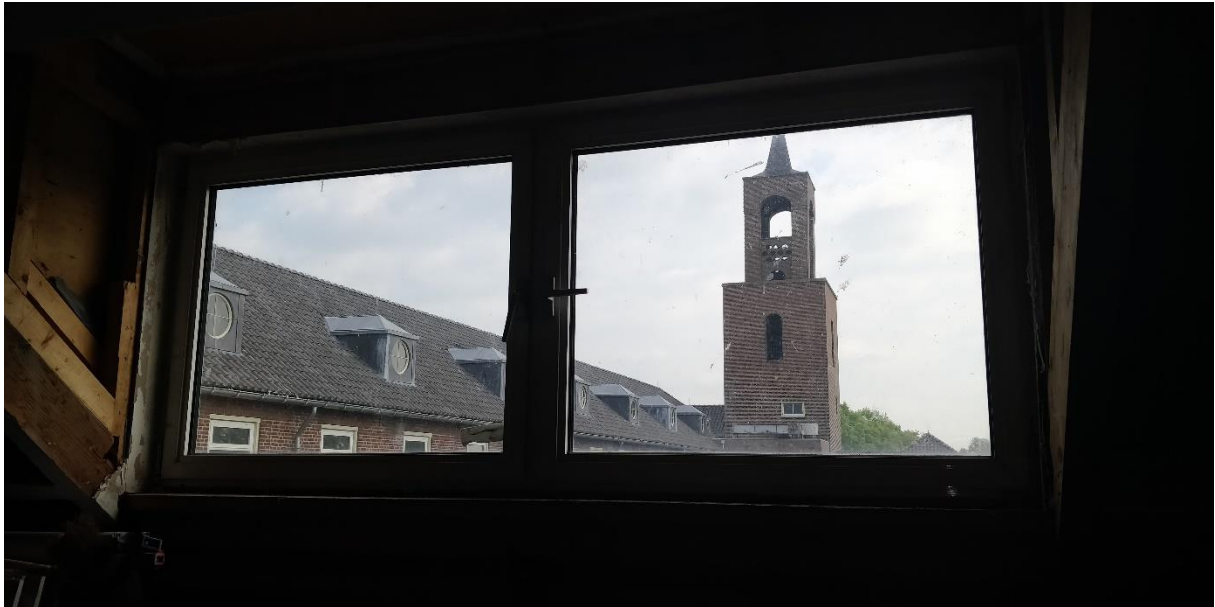
Foto 76: Raam aan zijkant van het gebouw met uitzicht op de toren.
