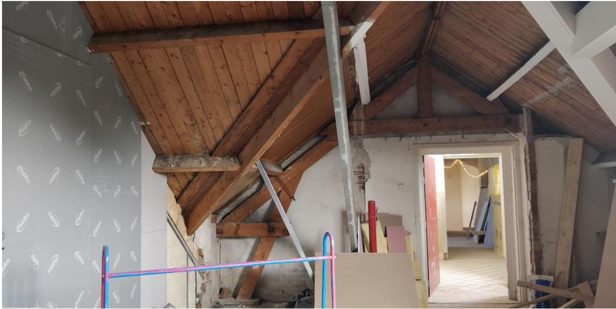
Foto 78: Dak zijkant hoofdgebouw.
