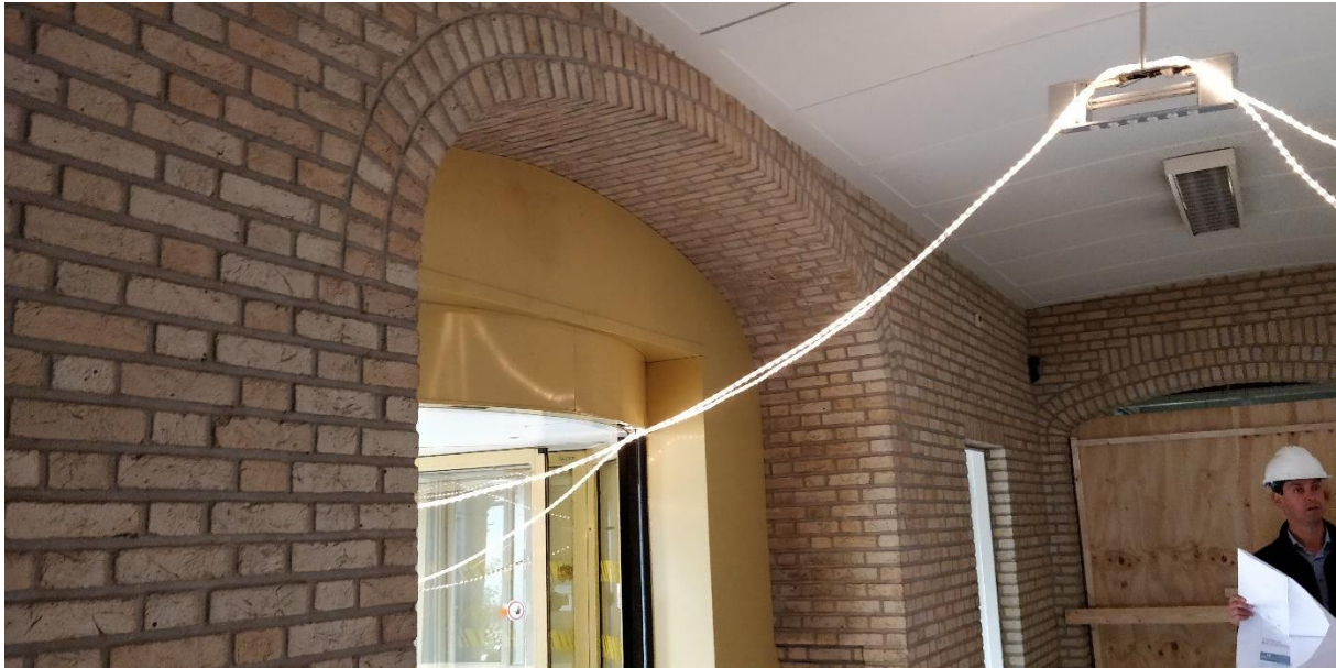
Foto 25: Bogen van metselwerk.
