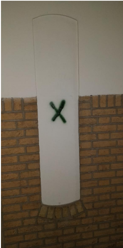
Foto 5: Dichtgemetseld raam aan de linkerkant van de bogen voor de trap.
