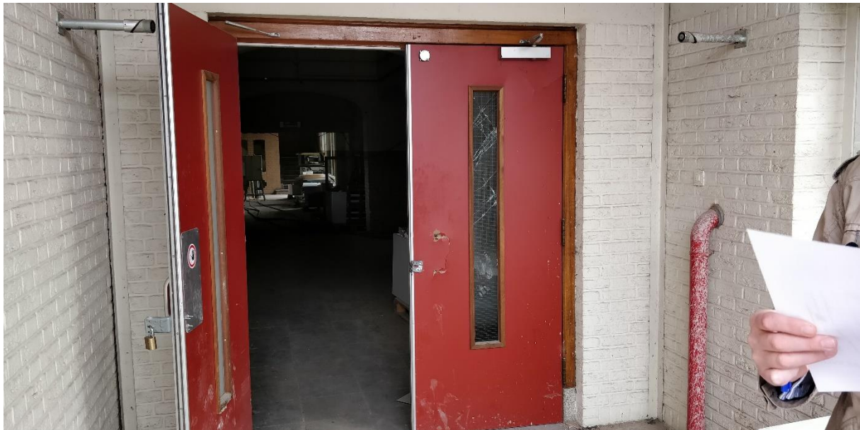
Foto 1: Ingang hoofdgebouw aan de kant van het economiegebouw
