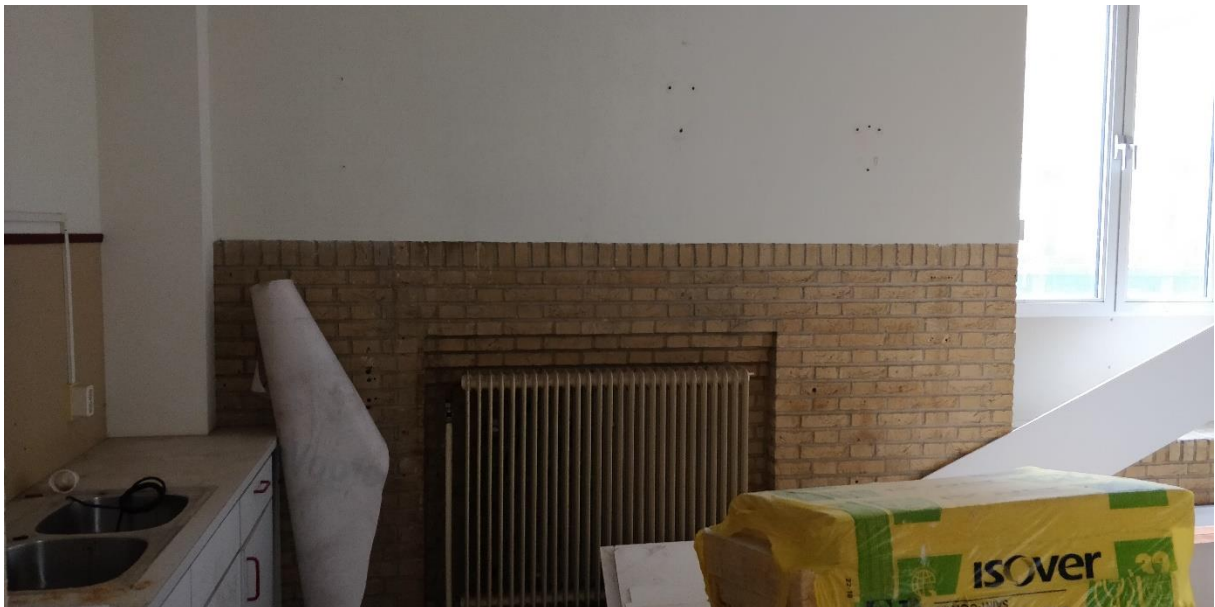
Foto 3: Lambrisering en radiator.
