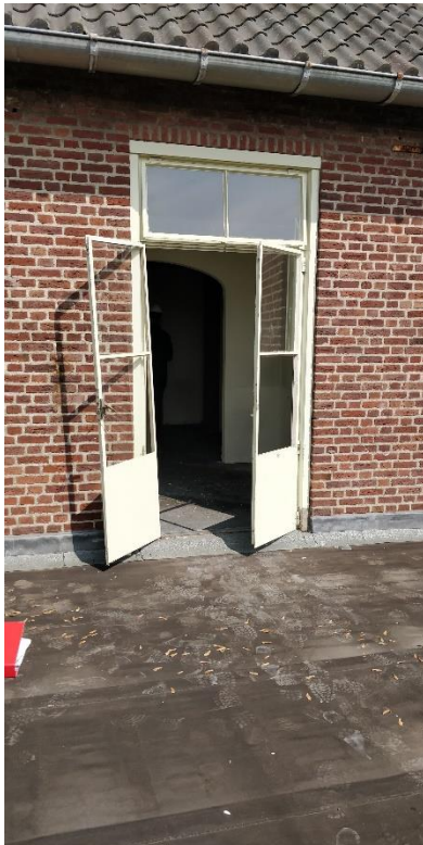
Foto 84: Dakterras vanaf de buitenkant.
