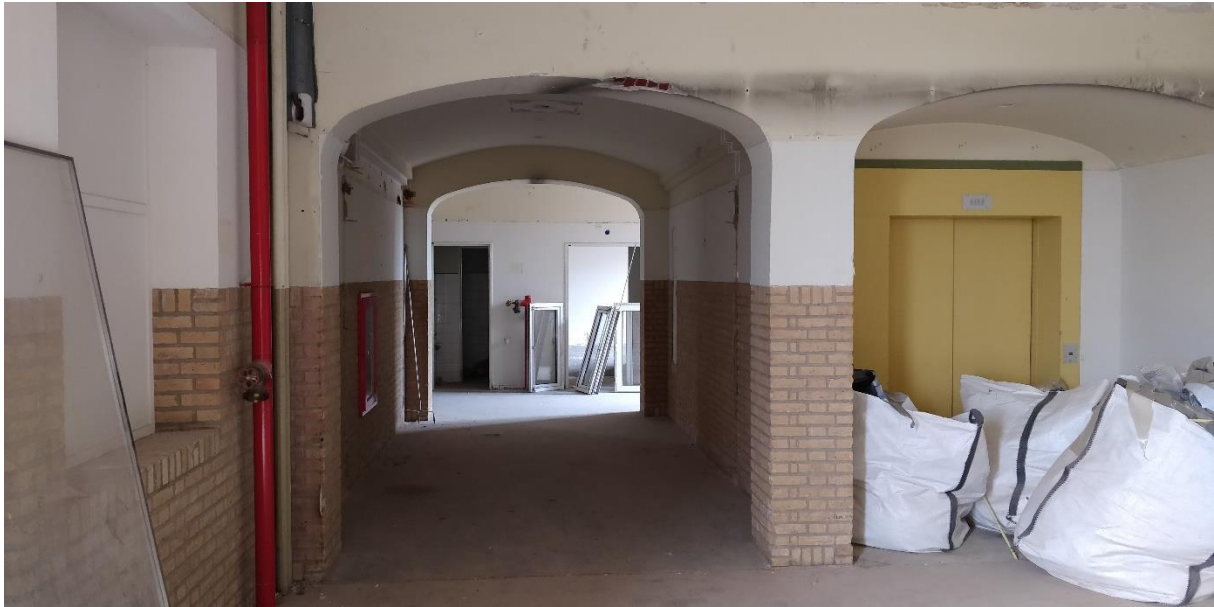
Foto 45: Ook aan deze kant bij de trap staan er twee bogen met lambrisering.
