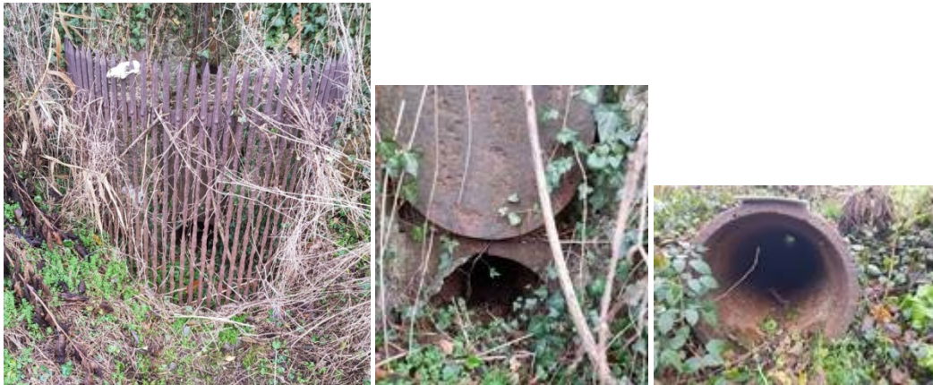
afb. Oude leegloopconstructie: vuilvang/ verstelbare schuif/ leegloop vijver buitenkant
