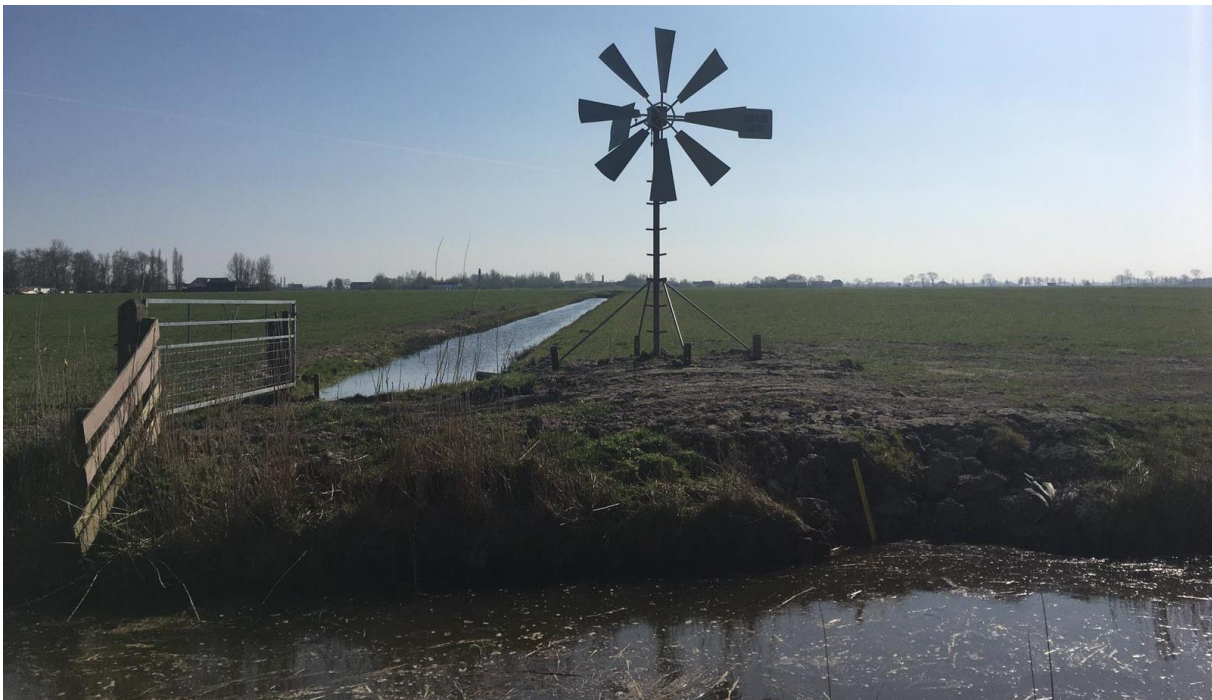
Figuur 1 - talud hoofdwatgang Rodewoldertocht ter plaatse van windmolen (foto d.d.9 april 2020)
