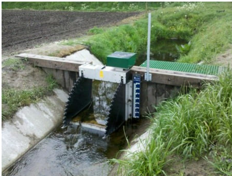
Figuur 3.2 Voorbeeld van de te plaatsen klepstuw
