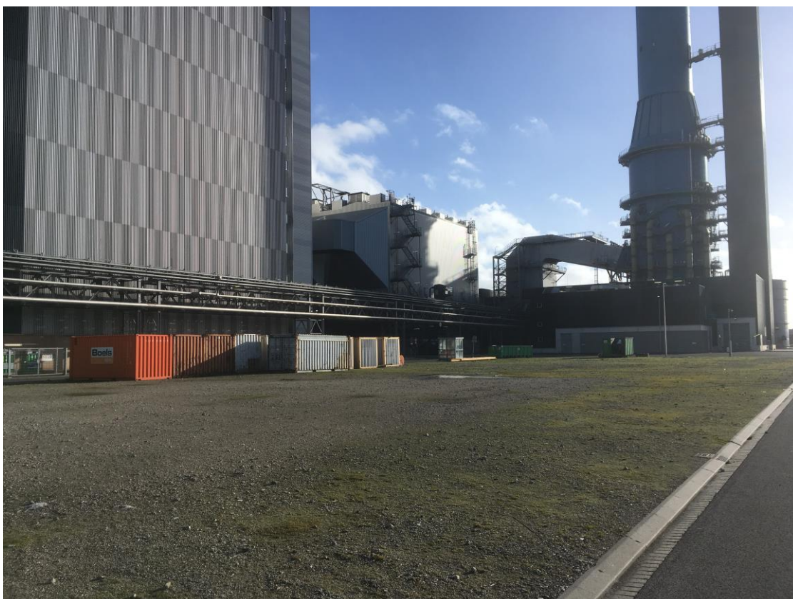
Foto 2. Situatie tweede deel nieuwe plant
