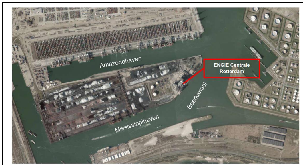
Fig 1. Ligging Engie Centrale in de Maasvlakte
