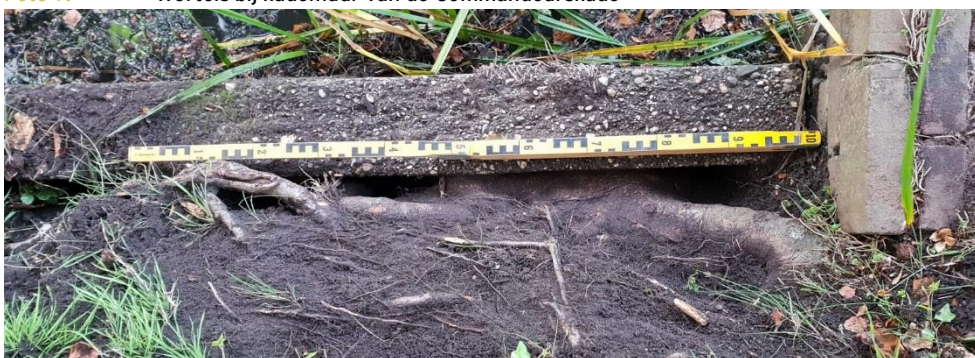
Foto 7. Wortels bij kademuur van de Commandeurskade
