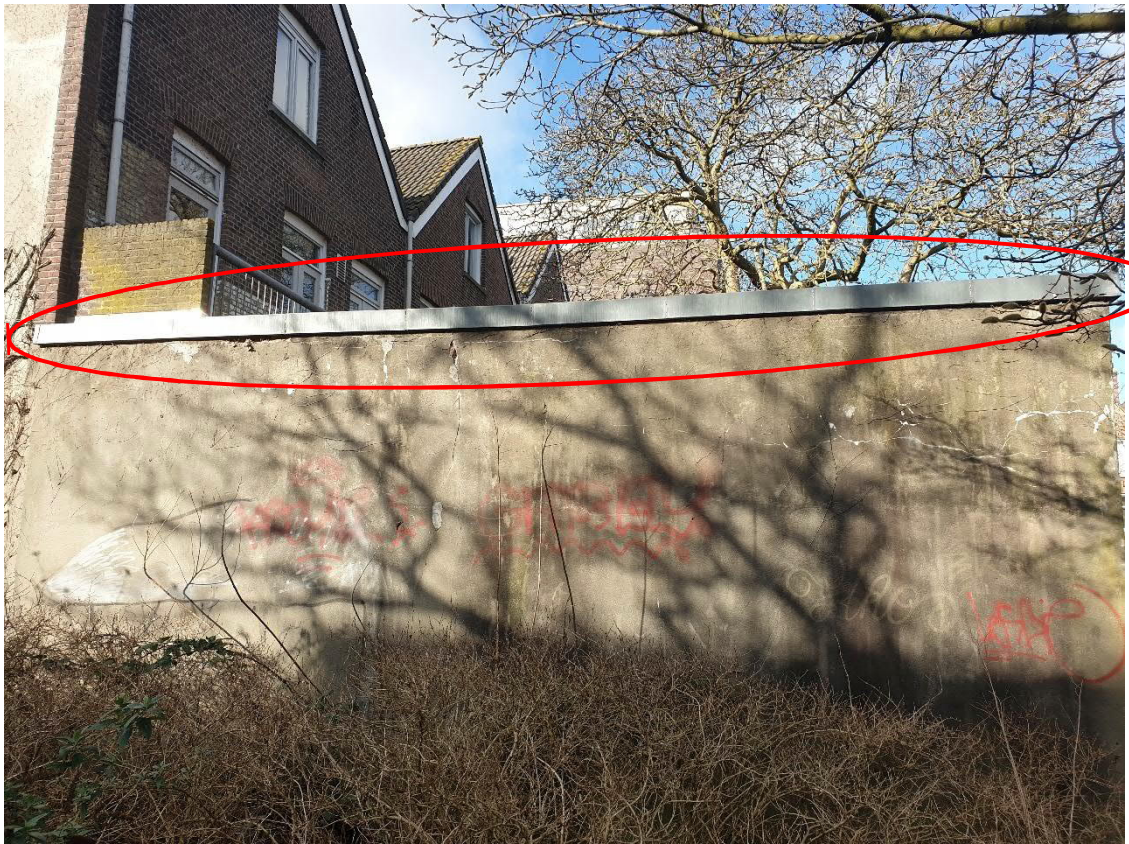
Foto 13 Overzicht zijkant Noordsingel perceel 77 met metalen afdekplaat rond opstaande muur (mogelijke verblijfplaats vleermuis (rode omkadering))
