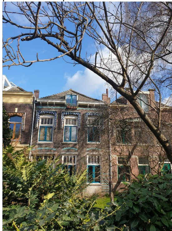
Foto 5 Voorgevel Noordsingel perceel 79
