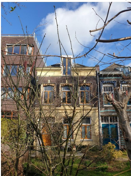
Foto 4 Voorgevel Noordsingel perceel 81
