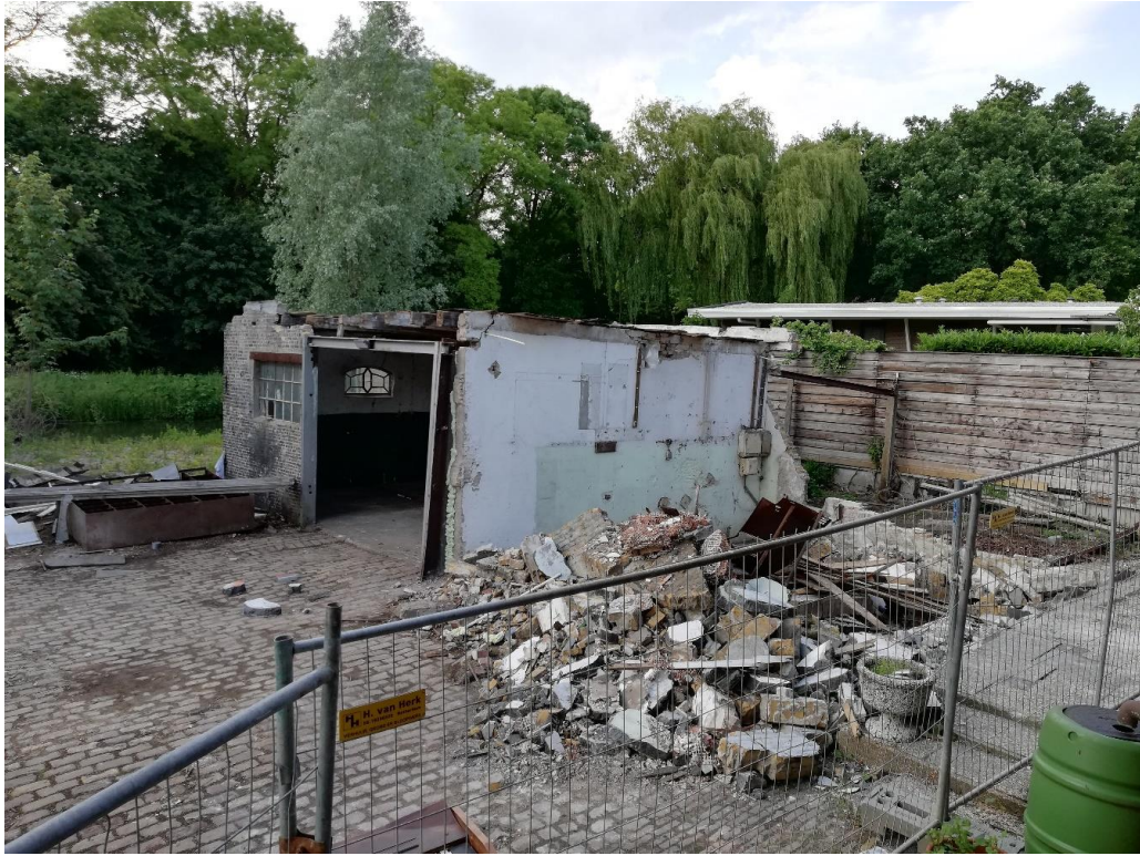
Figuur 1 Schuur A is deels gesloopt.
