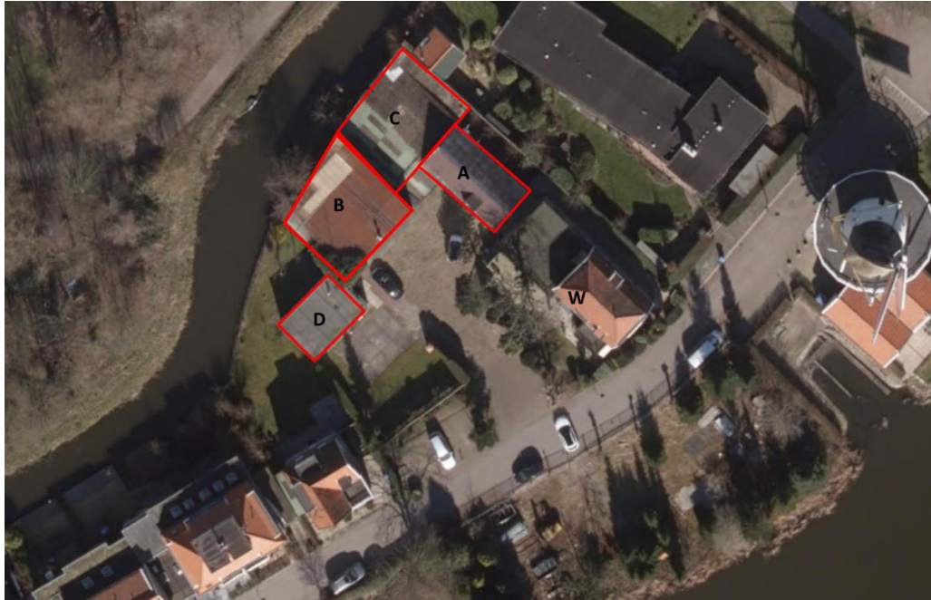
Figuur 2 De te slopen gebouwen op planlocatie (rood omkaderd). De woning is gemarkeerd met W en blijft behouden (bron: arcgis.com).
