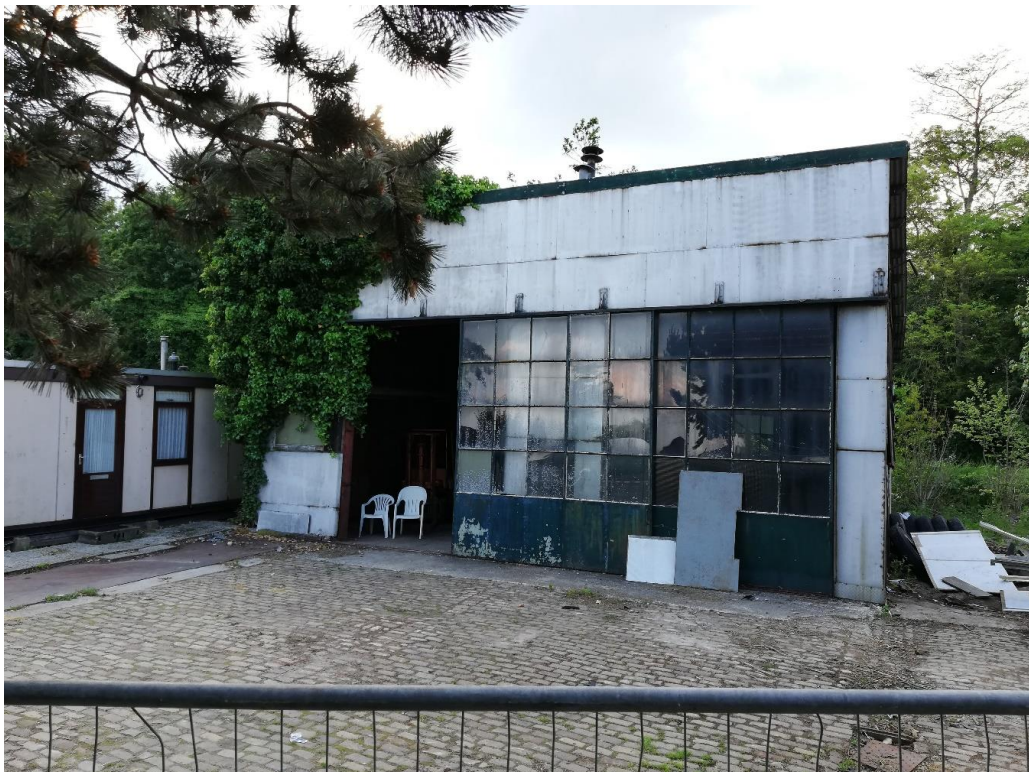
Figuur 2 Loods B is opgetrokken uit houten en metalen wanden.
