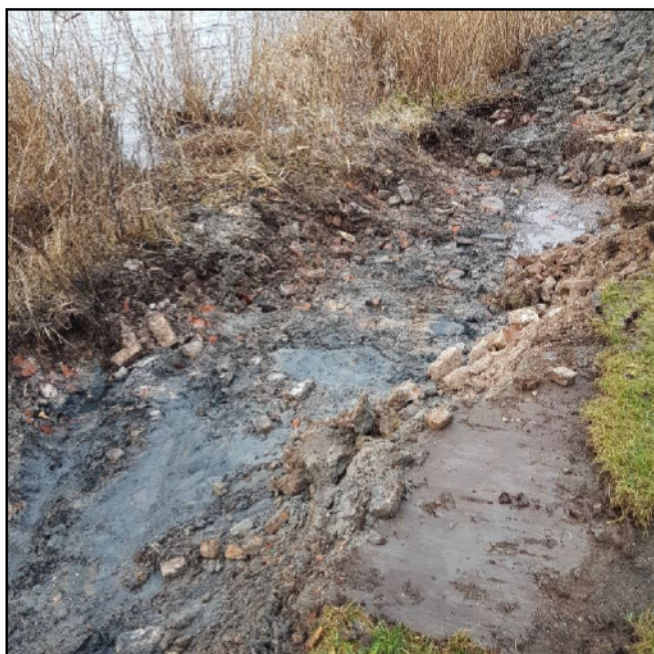
Foto 3 Te ontgraven puin tot op de waterlijn
