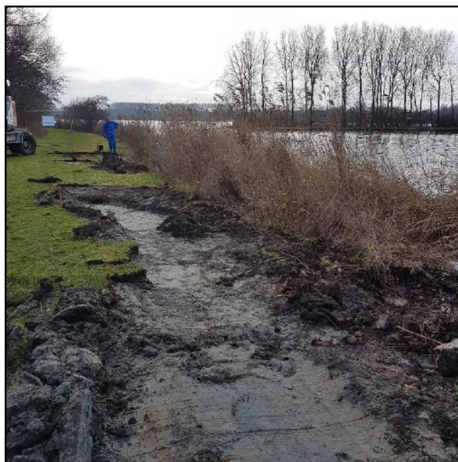
Foto 2 Start ontgraving oever
