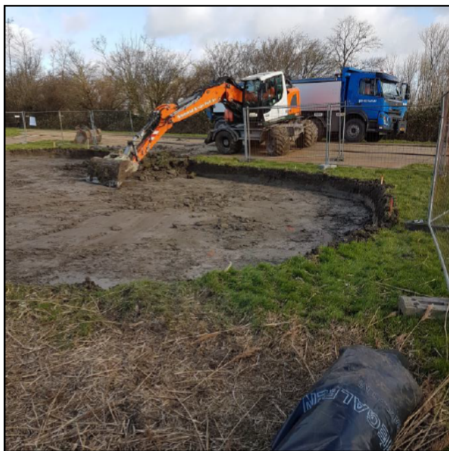
Foto 5 Verwijderen laatste rest verontreinigde grond
