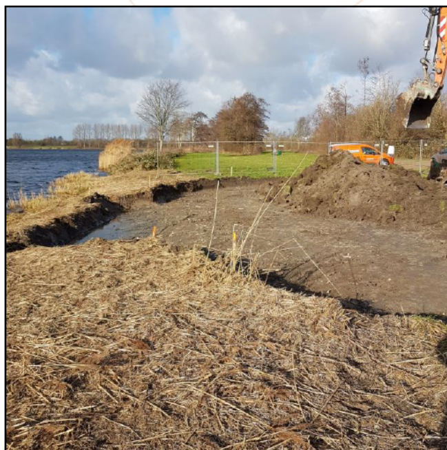
Foto 4 Ontgraving VP12, met resterend dammetje naar Brielse Meer
