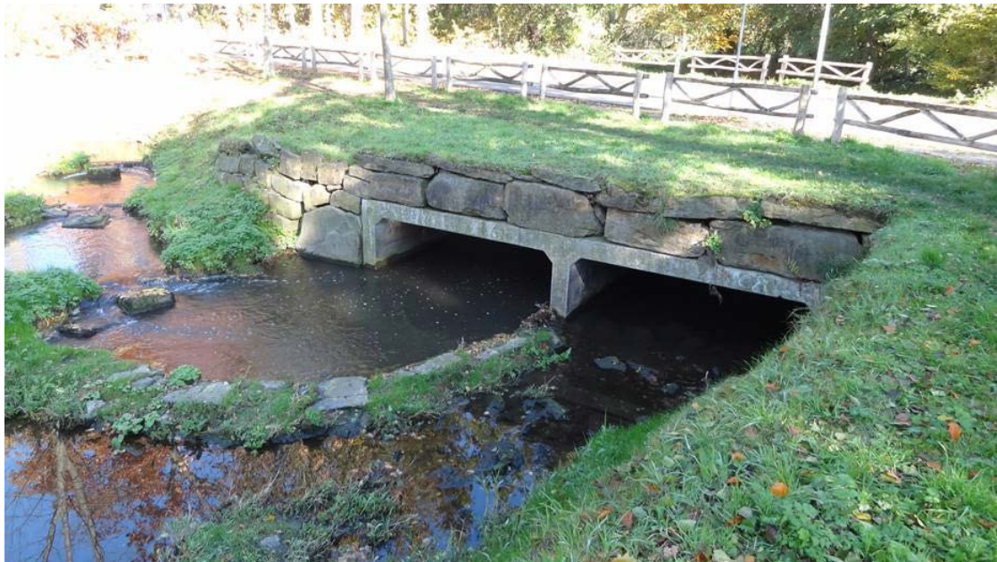
Figuur 6 De hoogwaterkokers onder de Molenweg.
