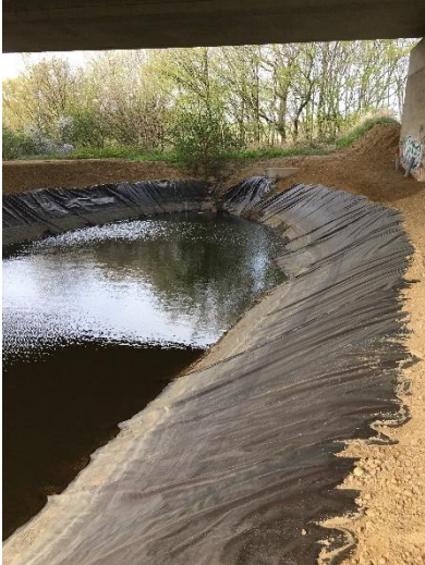
Figuur 9 Buffer onder dalviaduct
