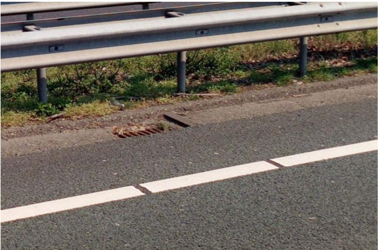
Figuur 13. Voorbeeld drempels achter kolk t.b.v. extra instroom neerslag
