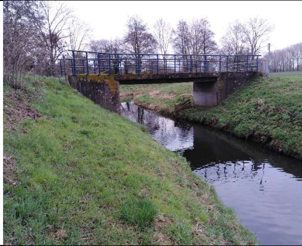
Brug over sleybeek (west)
