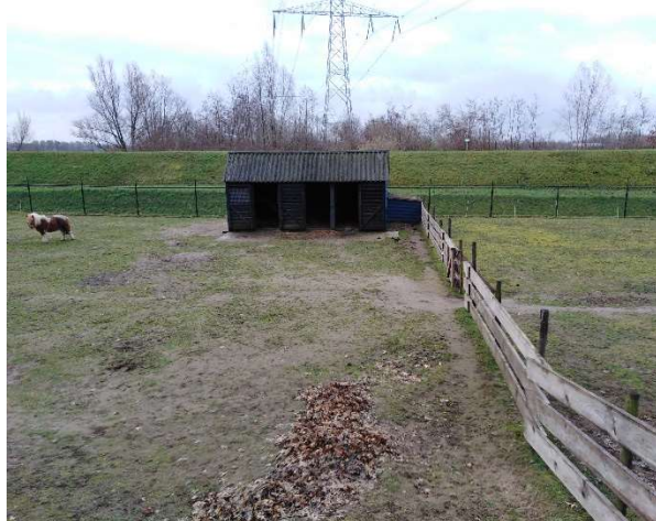
Ongefundeerd gebouw (oost)
