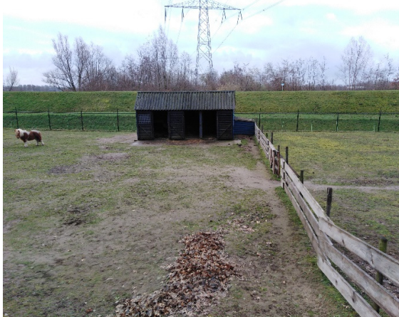
Ongefundeerd gebouw (oost)
