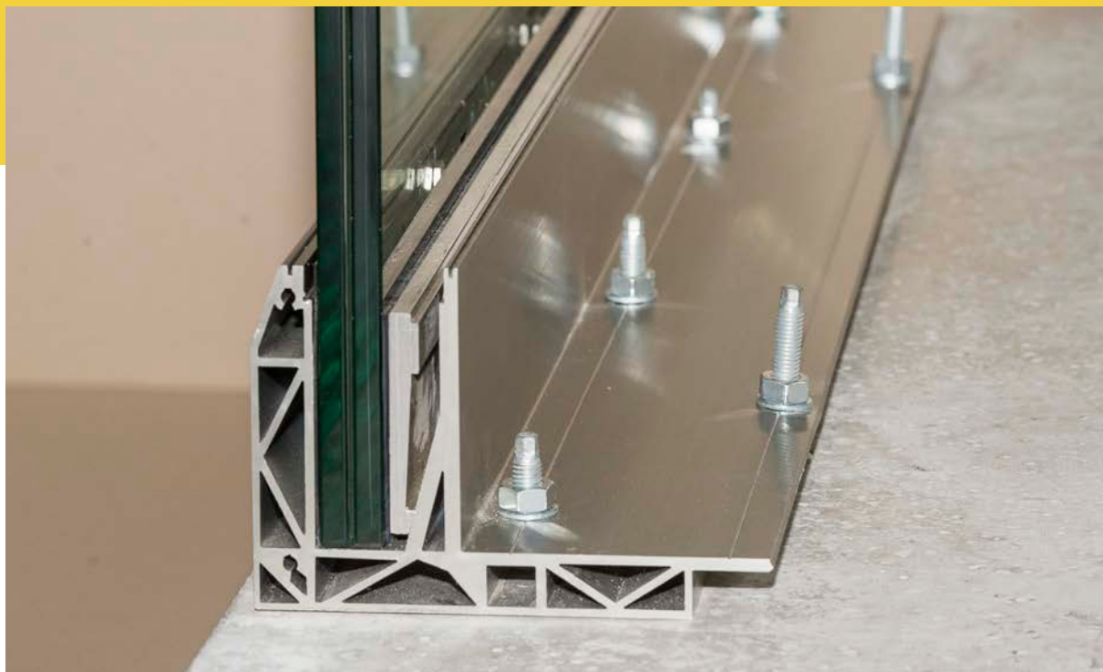
Goed te zien is de doorlopende klemstrip.
