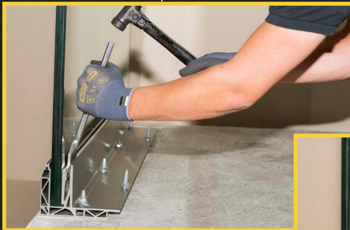
Aantikken van de klemstrip
