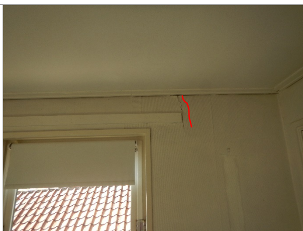
Afbeelding 5.10: scheur rechtsboven raam
