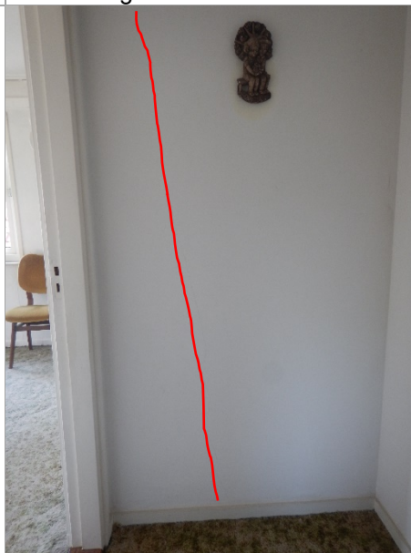
Afbeelding 5.14: scheur overloop
