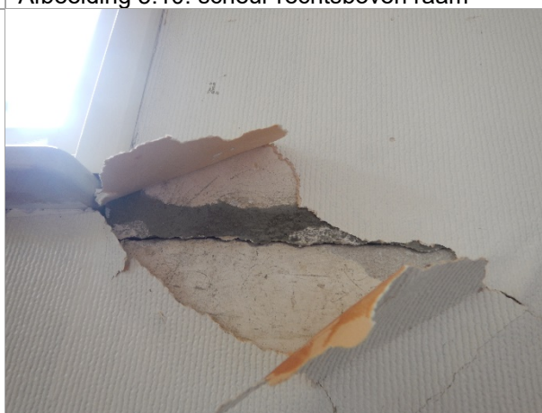
Afbeelding 5.12: scheur rechts van raam
