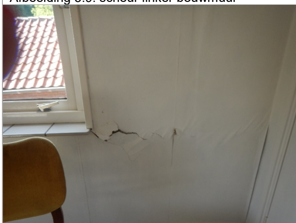
Afbeelding 5.11: scheur rechts van raam
