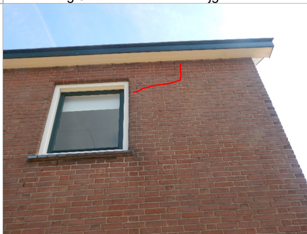
Afbeelding 5.4: scheur rechts boven raam
