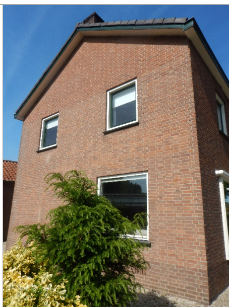
Afbeelding 5.2: overzicht linker zijgevel
