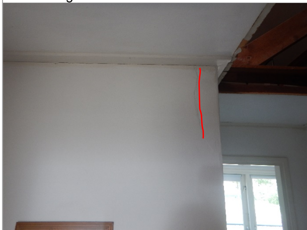
Afbeelding 5.13: scheur tussenmuur
