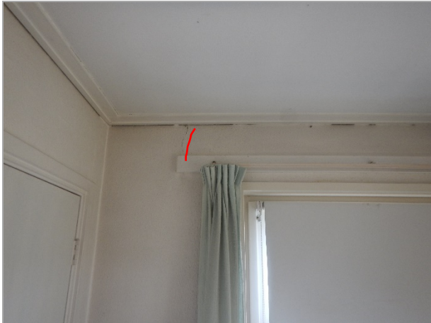
Afbeelding 5.15: scheur links boven raam
