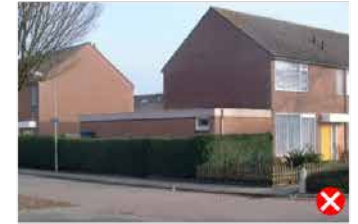
zijaanbouw te dicht bij voorgevelrooilijn
