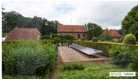
zonnepanelen passend op erf
