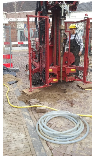
Foto 5: Uitvoering injecties
