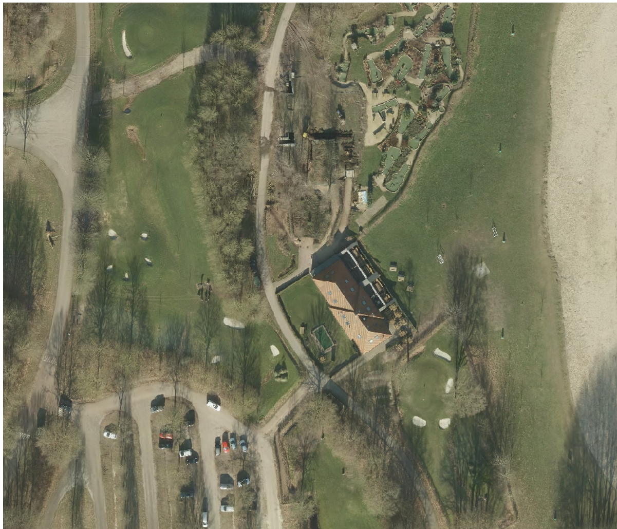
Afbeelding 3 - Luchtfoto bestaande situatie
