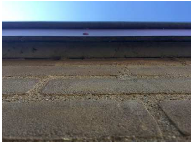
Onderaanzicht van de boeiboord. Deze is direct tegen de buitenmuur bevestigd waardoor vleermuizen er geen verblijfplaats achter kunnen bezetten.
