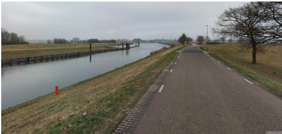
Figuur 9 - foto's van de Kanaaldijk: lindebomen langs het kanaal ter hoogte van sluizen-complex, brug & schotbalkenloods, strak dijkprofiel
