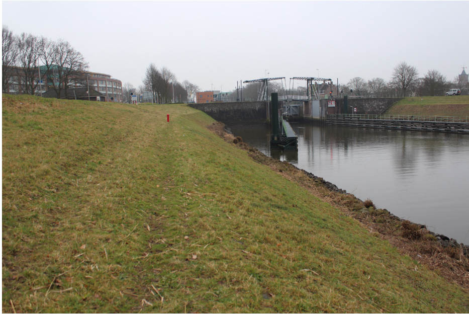
kanaaldijk en brug bij sluizencomplex
