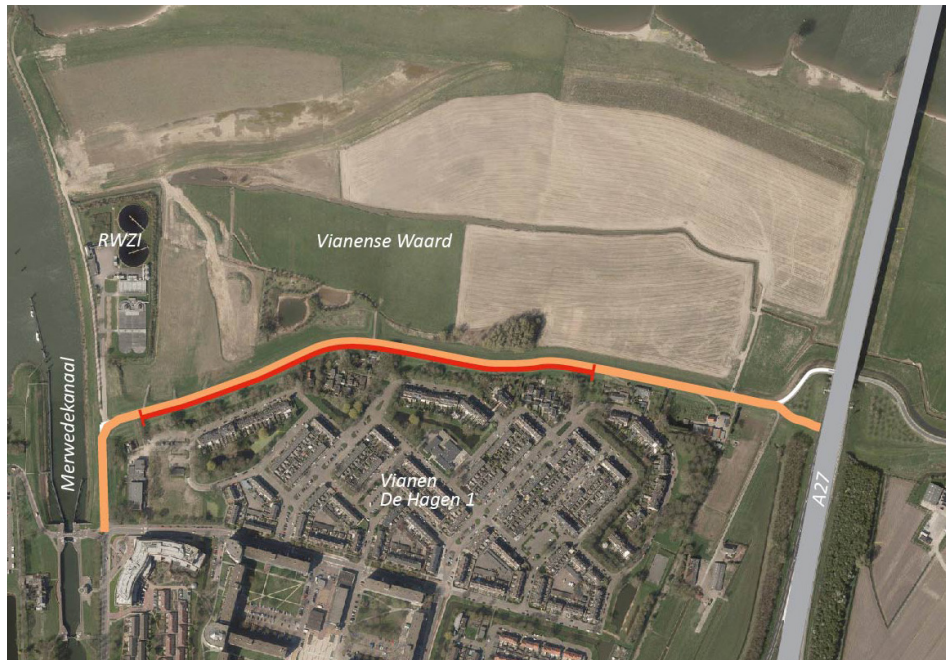
Figuur 2 - scope dijkverbetering, in rood het deel van de dijk dat is afgekeurd op piping
