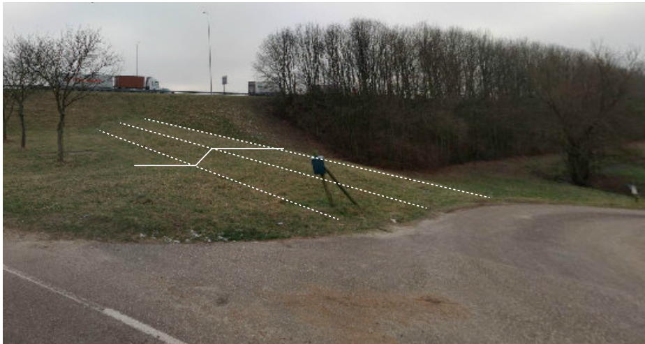
Figuur 14 - zichtbaarheid van het dijctracé ter hoogte van het grondwerk
