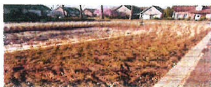
Figuur 21: nieuwe aanleg plantsoen met hemelwaterinfiltratie
