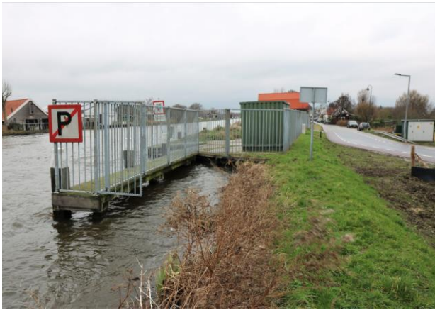
Afbeelding 2.1 | Zuidelijkste punt van de oever waar damwand wordt geplaatst
