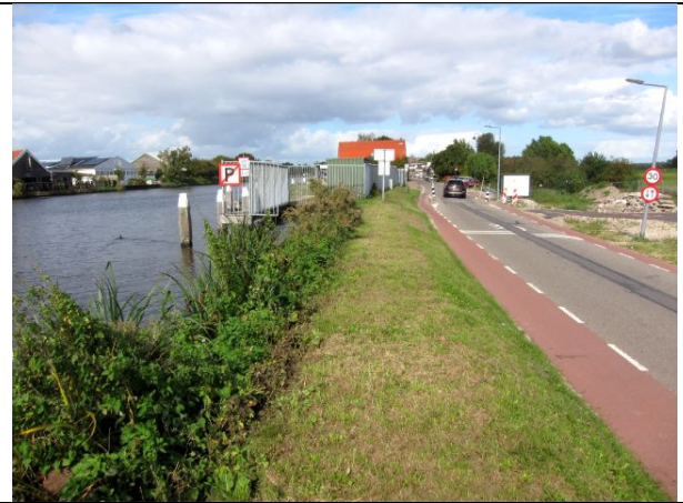
b) Delftweg buiten bebouwde kern
