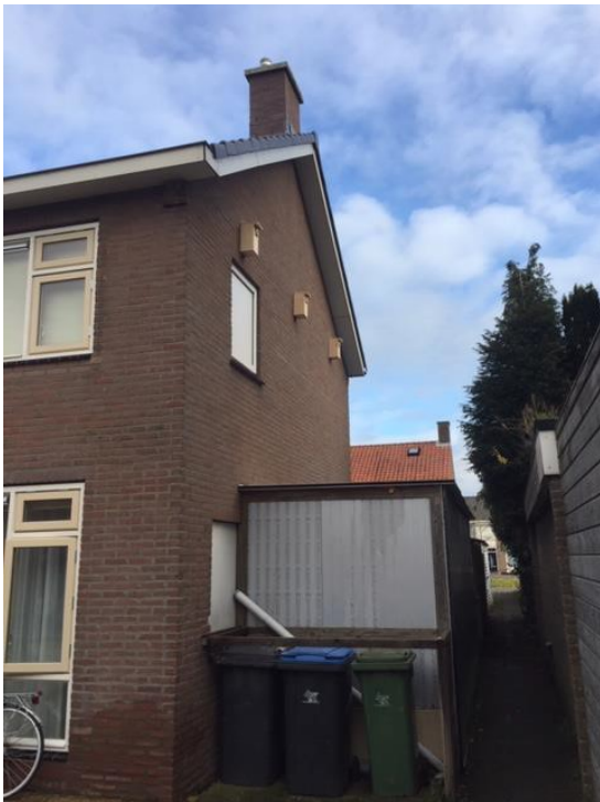
Foto 2. Foto geplaatste kasten in de Plevierstraat in Zaltbommel
