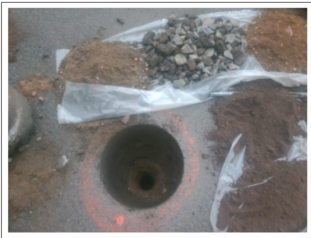
Foto 9. Asbestinspectiegat G09
