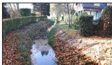
Figuur 7. Tielebeek tussen de woningen ten westen van de Langstraat.
