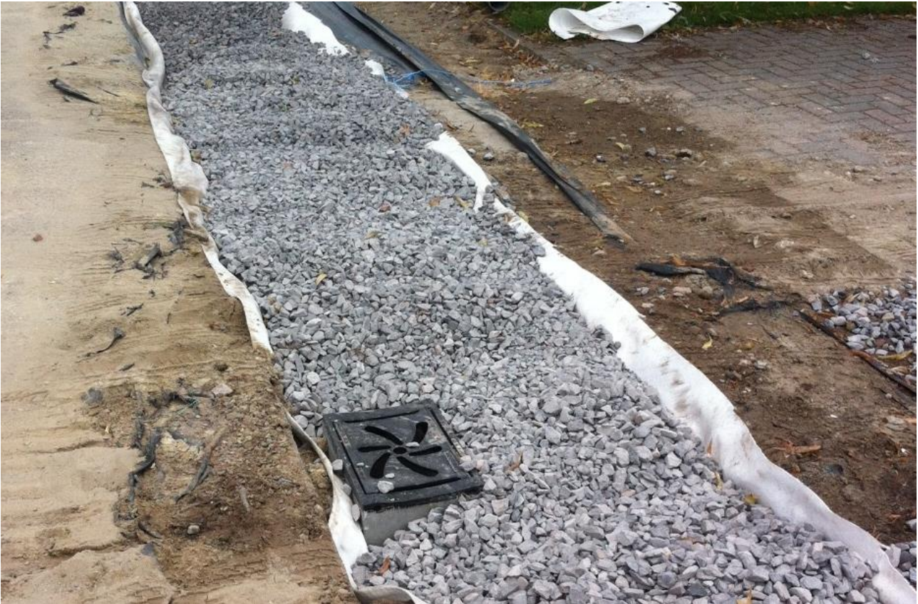
Afbeelding 4.6: Infiltratiestrook voor hemelwater (bron: gemeente Bergeijk)
