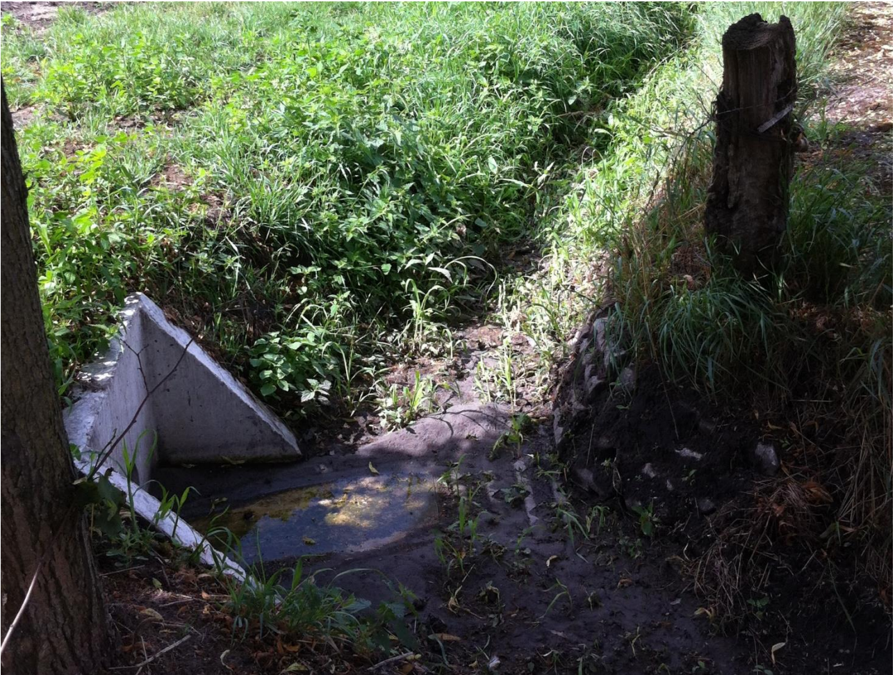
Afbeelding 4.7: Uitstroomvoorziening afgekoppeld hemelwater (bron: gemeente Bergeijk)
