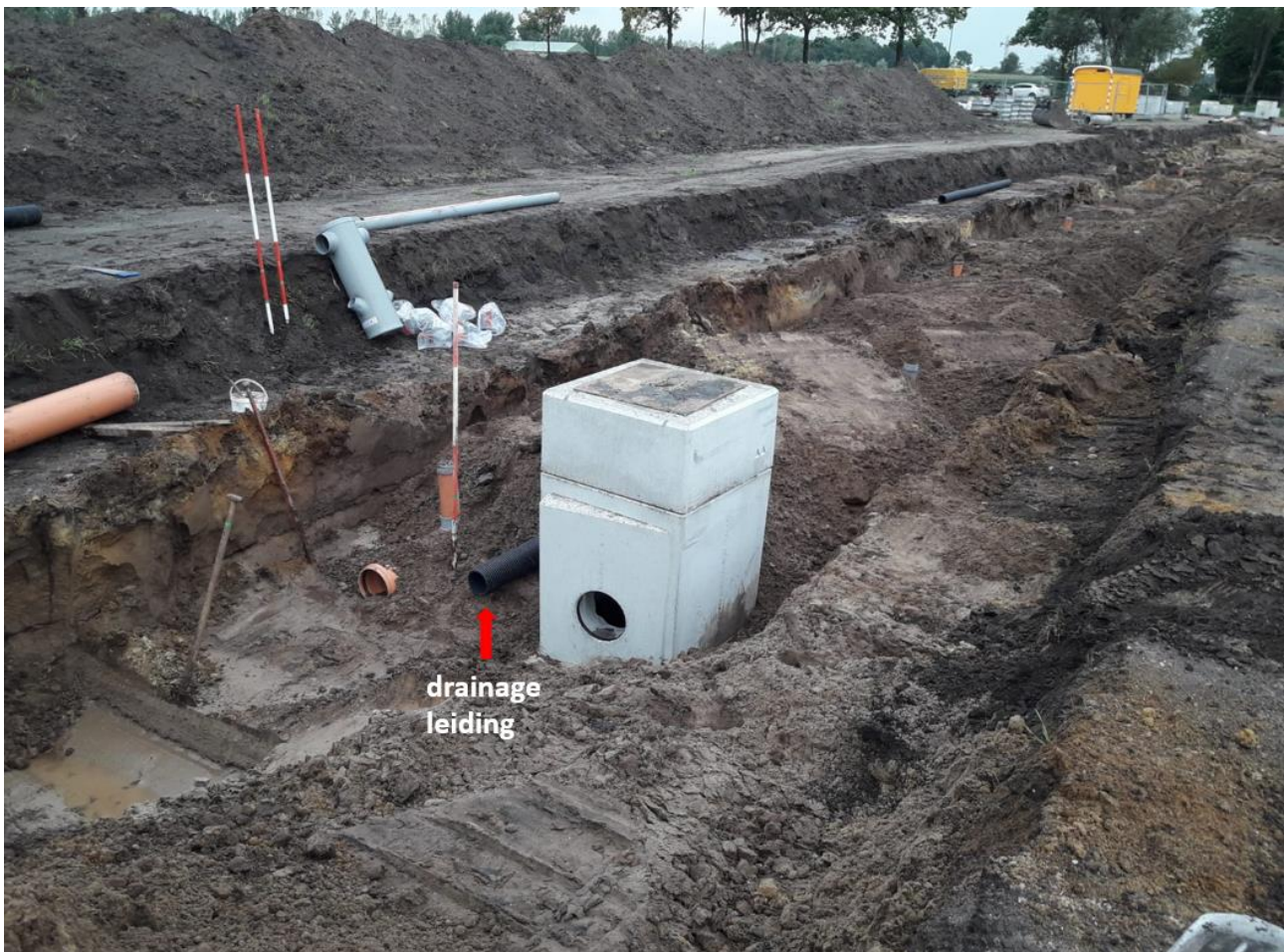
Afbeelding 4.9: drainage zorgt ervoor dat de grondwaterstand niet te hoog komt (bron: Stichting Rioned)
