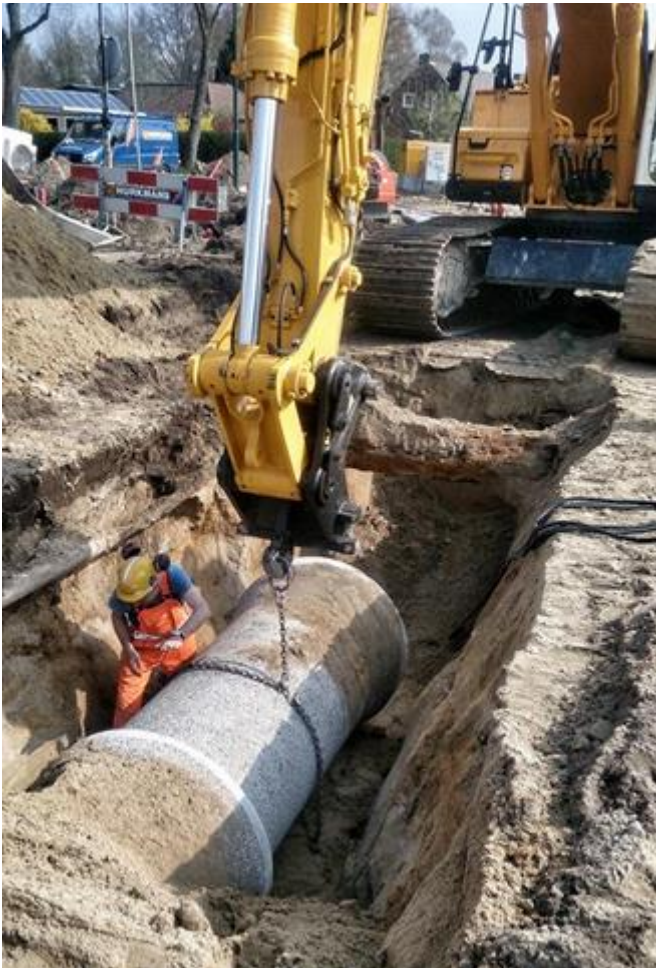
Afbeelding 4.3: Renovatie van riolen blijft een opgave (bron: gemeente Bergeijk)
