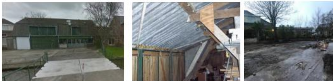
Situatie voor de sloop (links) – binnen en na de sloop
