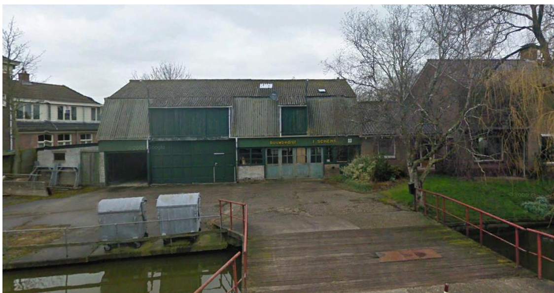
afb. 3 Het aanzicht van de - sterk verouderde - schuur (inmiddels gesloopt).
