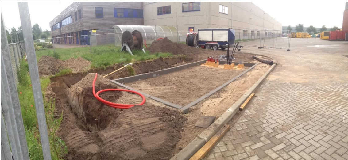
Foto 1: Voorbereiden fundatie, en aanbrengen kabels en leidingen
