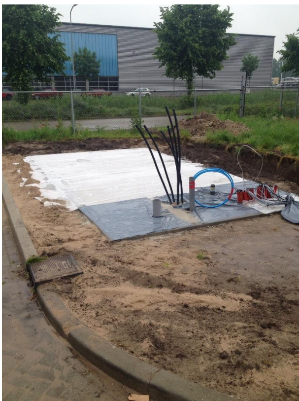
Foto 2: Aanbrengen werkvloer
