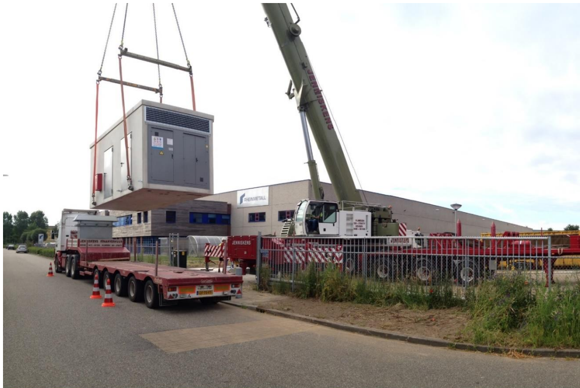
Foto 3: Plaatsen prefab behuizing
