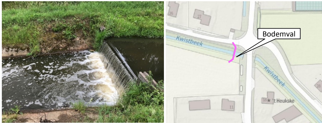
Figuur 4-29: Vervangen in- en uitstroomvoorziening
