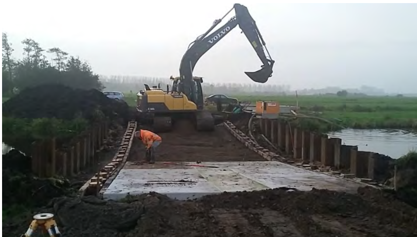
Figuur 8.1 Aanleg onderwaterdam in polder Bloemendaal
