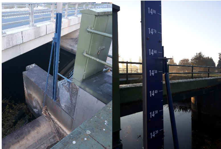
Figuur 4.7 Mechanische aanwezige peilschaal
