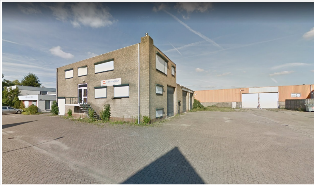
Impressie van het plangebied naar het noorden georiënteerd met de huidige bedrijfsmatige opstallen en de bedrijfswoningen
