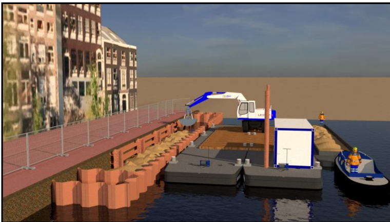
15. Aanbrengen zand en klei
