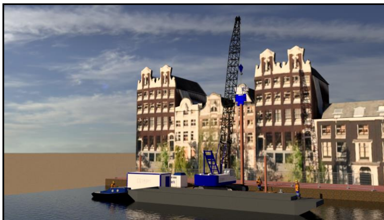
3. Trillend aanbrengen HEB600
