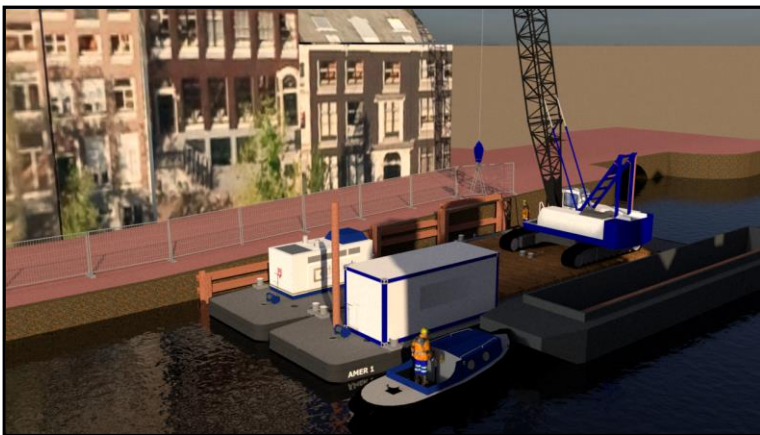
7. Aanbrengen HEB300 gording
