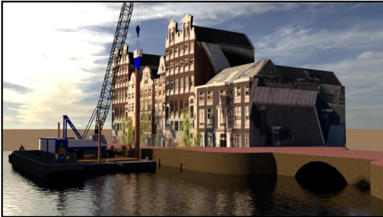
5. Trillend aanbrengen HEB600
