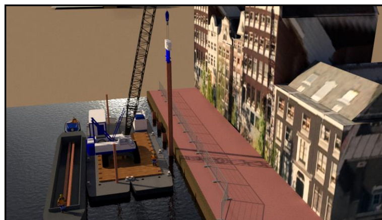
4. Trillend aanbrengen HEB600
