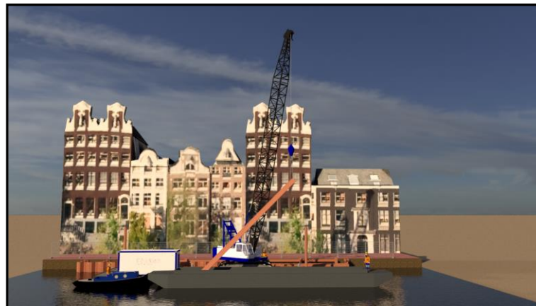
8. Trillend aanbrengen damwand
