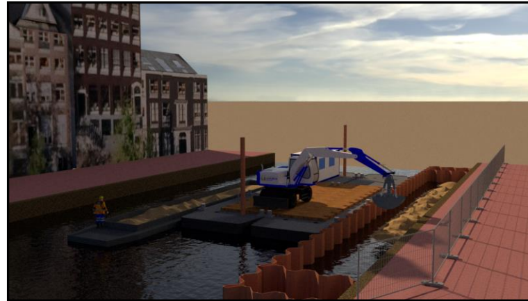
7. Kuip met zand aanvullen (Beunbak aan kopzijde om doorvaart te verbreden)
