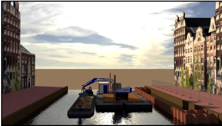
8. Kuip met zand aanvullen (Beunbak aan kopzijde om doorvaart te verbreden)
