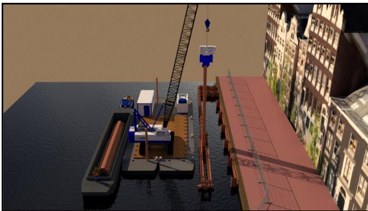
11. Trillend aanbrengen damwand
