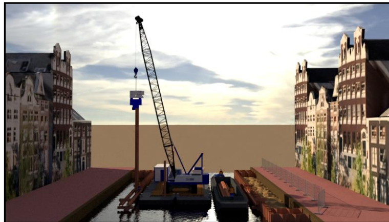
5. Aanbrengen damwanden met heigording (Beunbak aan kopzijde om doorvaart te verbreden)
