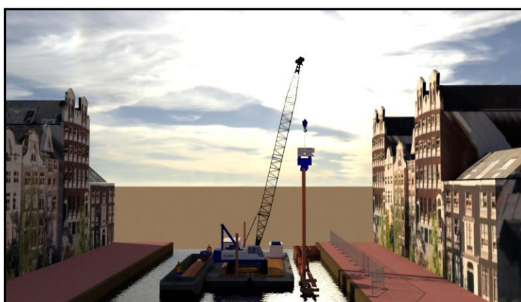
4. Aanbrengen damwanden met heigording
