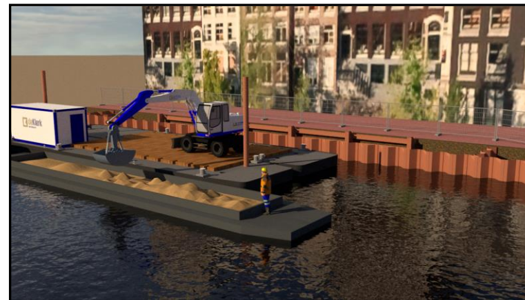
12. Aanbrengen zand en klei
