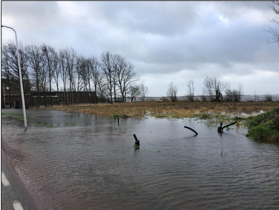
Afbeelding 3-3 wateroverlast in 2018 door overslaand water over de waterkering op de Herenweg, Braassemmeer is op de achtergrond te zien.
