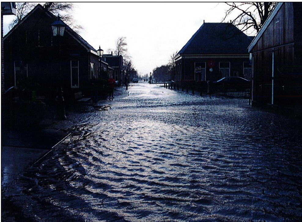
Afbeelding 3-2 wateroverlast in 2007 door overslaand water over de waterkering op de Herenweg, Braassemermeer en H.L. Breenkade liggen links op de foto.
