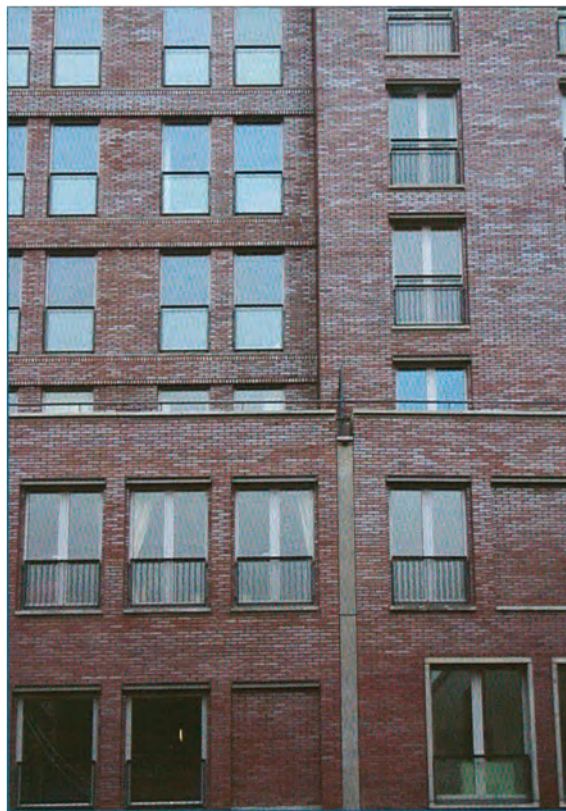
Referentie paars-rood metselwerk
