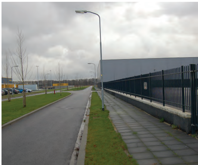
Giga: betonmuur + hekwerk
