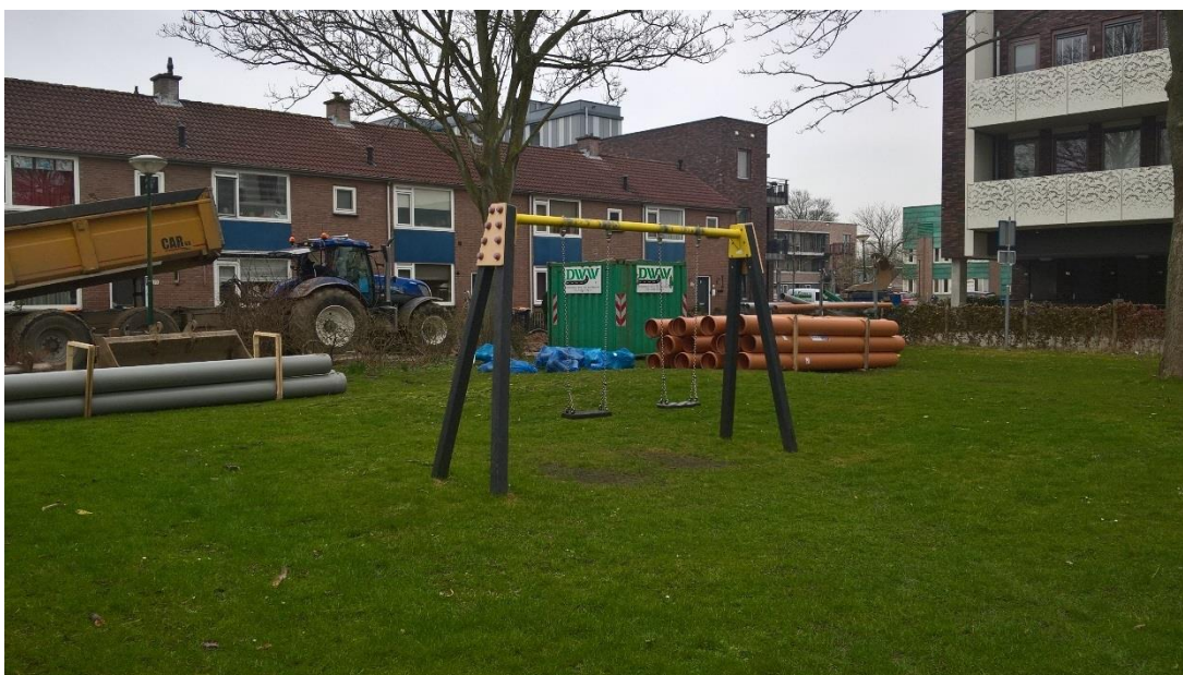
Figuur 8 Werkzaamheden in de Engk, waarbij riolering en de bovengrondse inrichting zijn aangepakt
