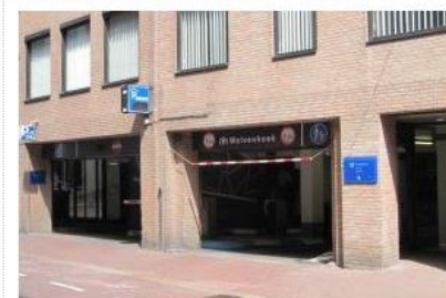
Fietsenstalling Den Bosch - Wolvenhoek / De Kuil
