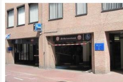
Fietsenstalling Den Bosch - Wolvenhoek / De Kuil
