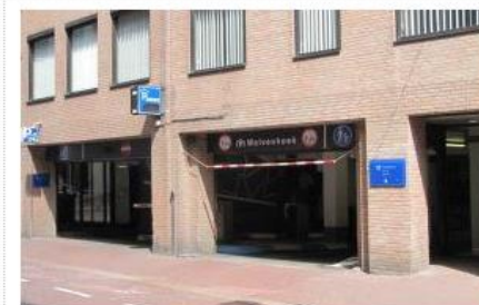
Fietsenstalling Den Bosch - Wolvenhoek / De Kuil
