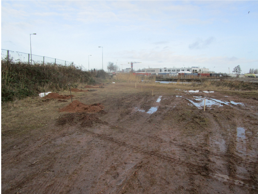
Overzicht terrein fase 1
