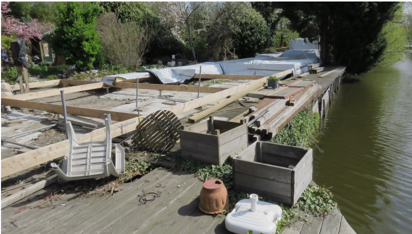
Afbeelding 3: Zicht op de bouwlocatie, kijkrichting oost
