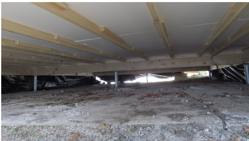
Afbeelding 7: Onder de fundering werden geen sporen van steenmarter aangetroffen.
