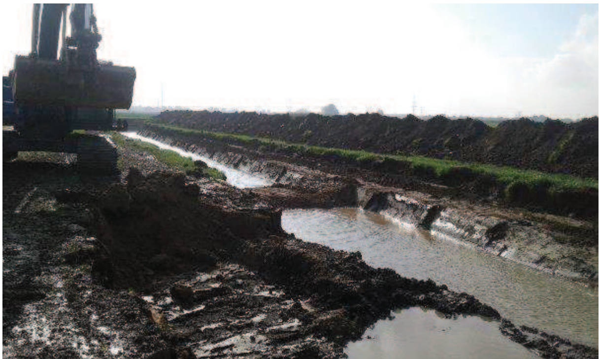
Ontgraving slootdemping
