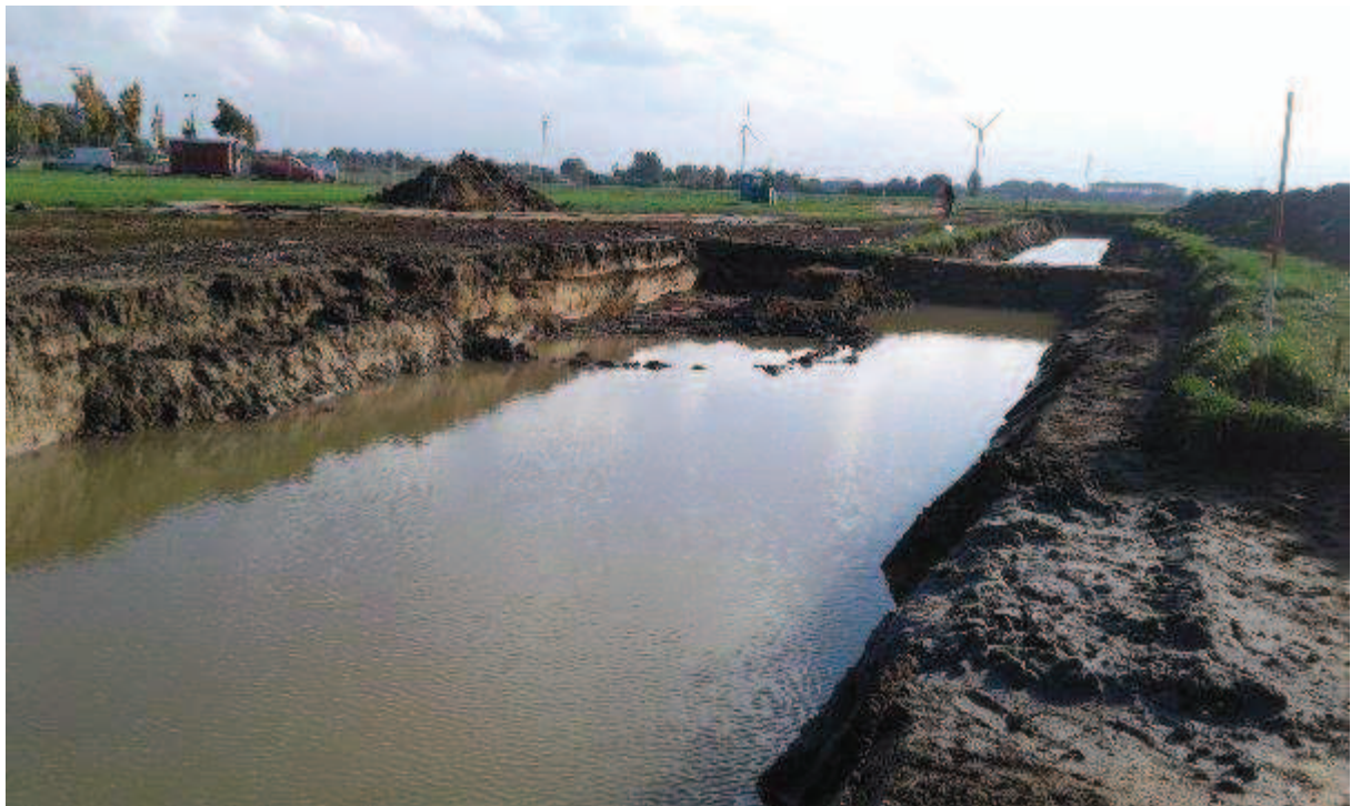
Ontgraving slootdemping 1
