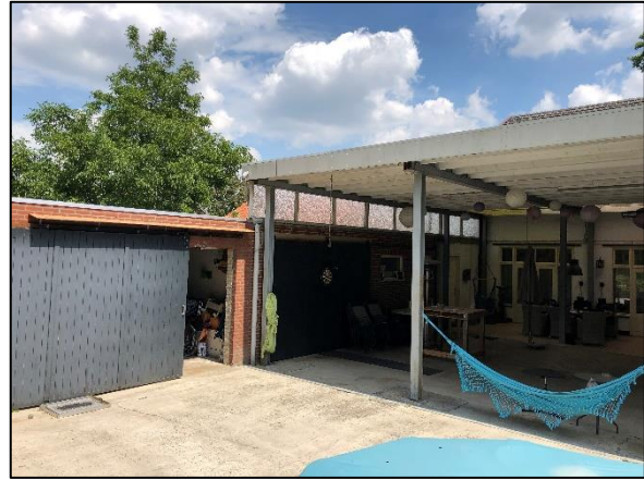
Afbeelding 9. Achterzijde van het pand, zijnde de overkapping en bijgebouw
